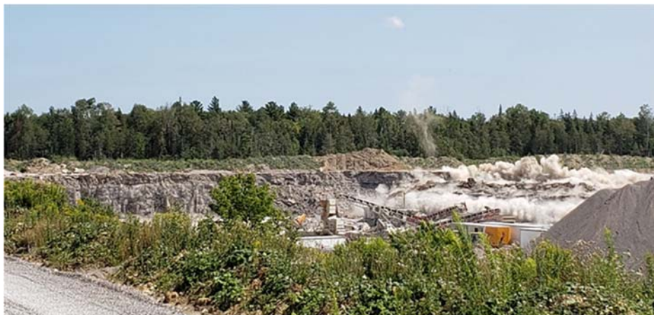
Une carrière d'agrégats de calcaire de construction conduisant une explosion.
